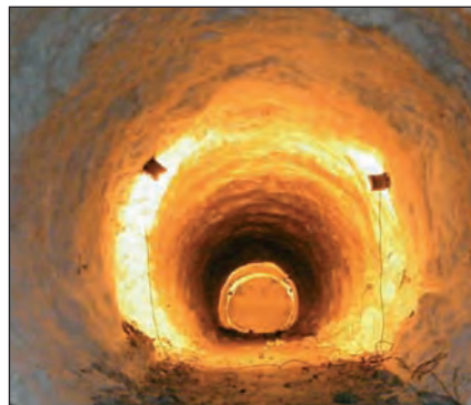
Figures 26 et 27 - Tunnel pilote congelé de 5 m de diamètre avant et pendant le percement par le tunnelier de 10,6 m de diamètre.
