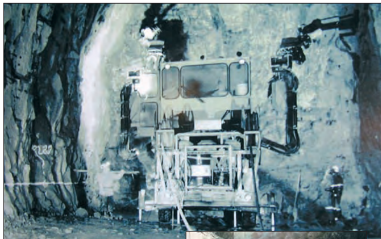
Figures 4 et 5 - Les deux premières tentatives : tunnelier ouvert à grappeurs et méthode du forage et dynamitage.
