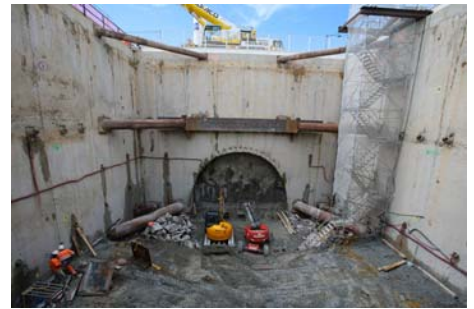
Travaux de réalisation Puits d'introduction du tunnelier © D. Gouray
