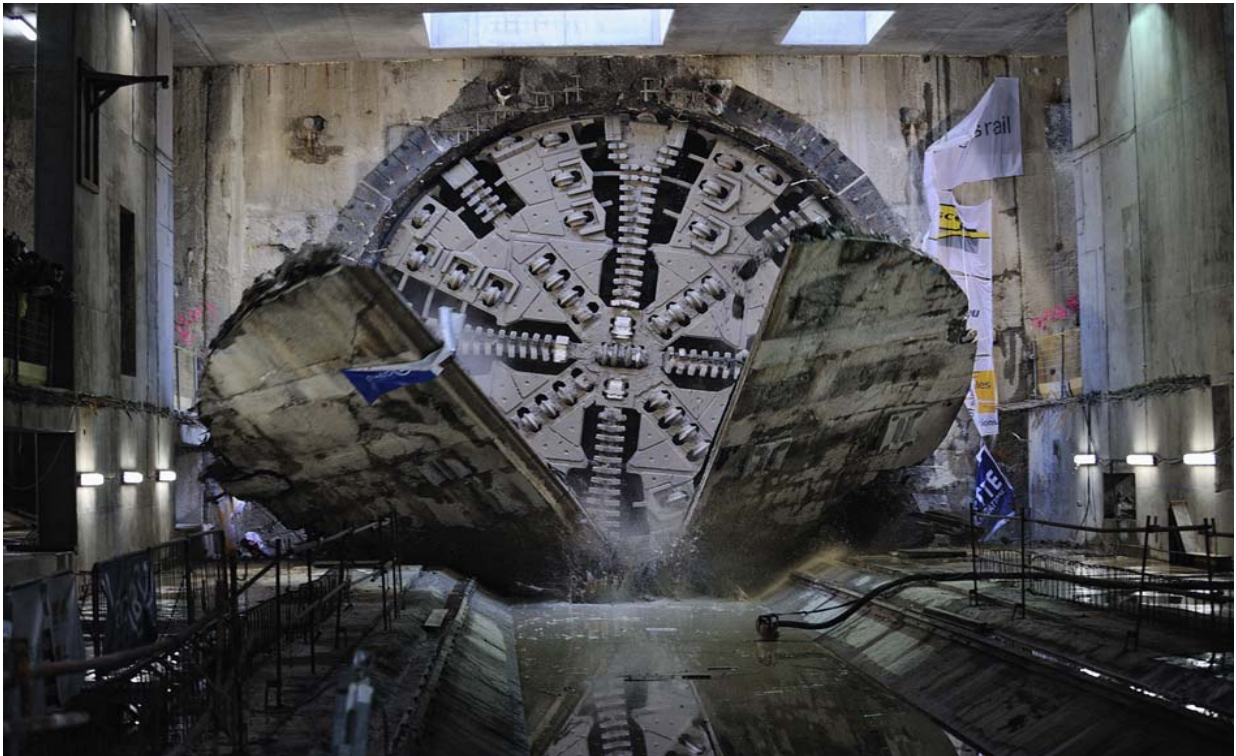
Roue de coupe en action lors de la réalisation du prolongement de la ligne B du métro de Lyon, à Oullins
