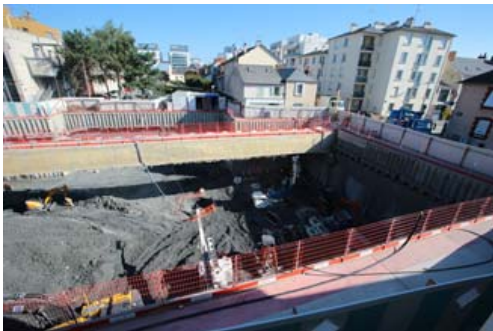
Travaux de réalisation de la station Mabilais © D. Gouray
