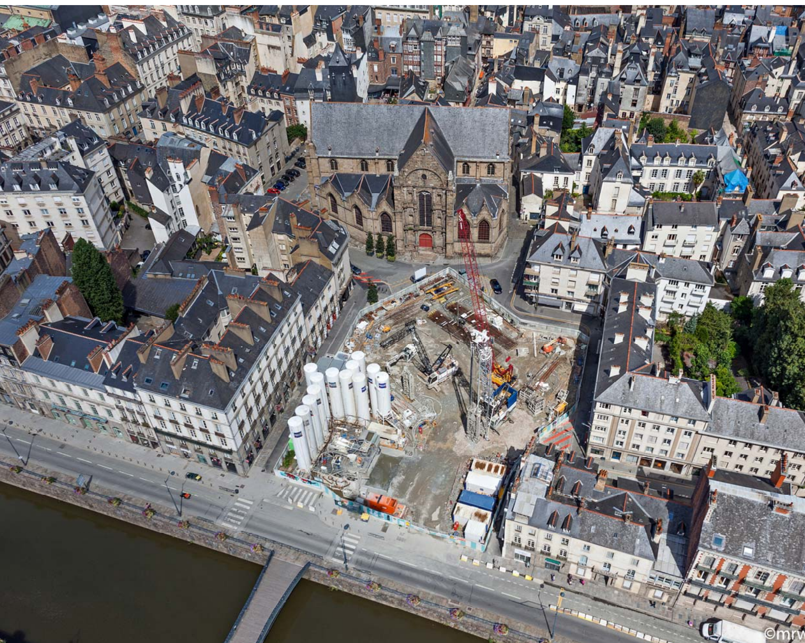
Chantier de réalisation de la station Saint-Germain – été 2014
