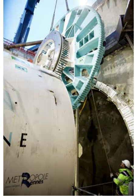
Descente de la roue de coupe du tunnelier © C. Simonato
