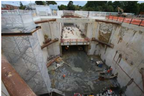
Travaux de réalisation Puits d'introduction du tunnelier © D. Gouray
